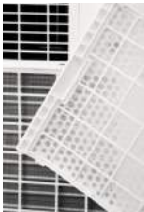
Fig 1. Apague a unidade e retire os 2 filtros de ar.
